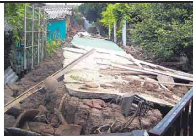
Ceroni quedó atrapado en su patio por un derrumbe.
