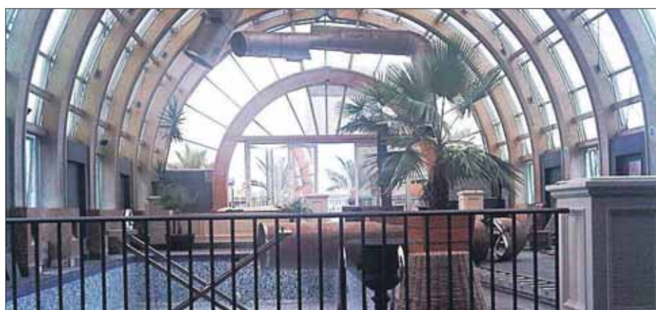
Los tubos del aire acondicionado en la piscina del The Ritz-Carlton se cayeron. El agua fue extraída por razones de seguridad.
