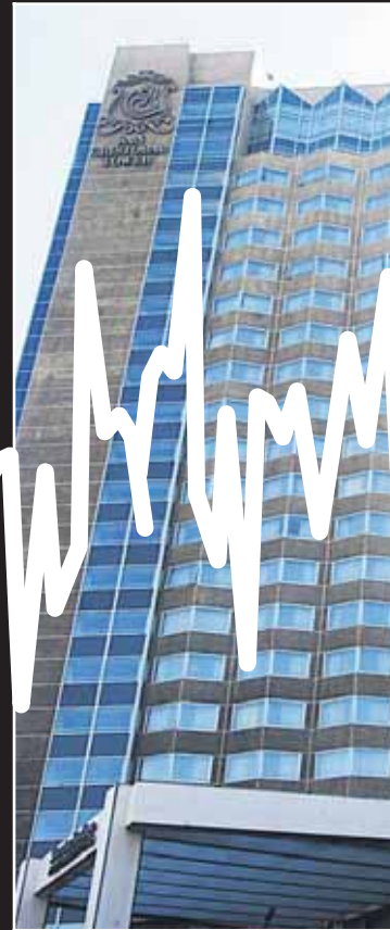
Desde el SHERATON se podían ver derrumbes en el cerro.
