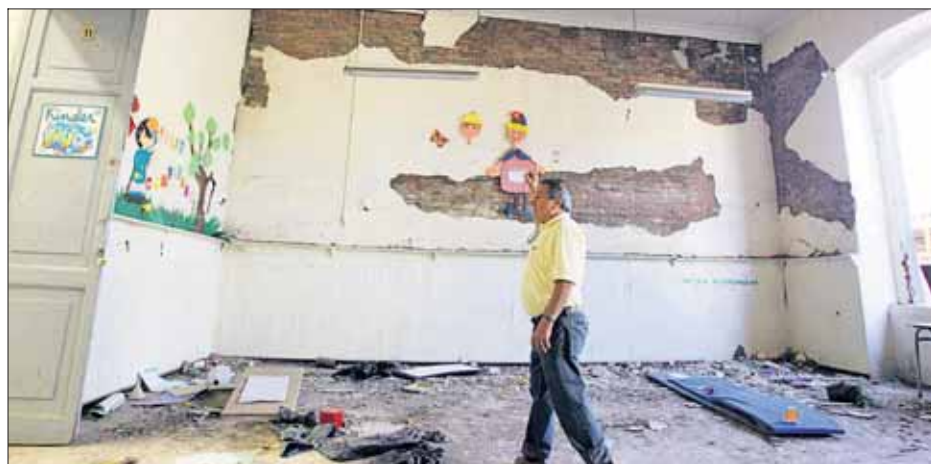
El Liceo Superior de Hombres, levantado en 1890 y que postulaba a ser declarado patrimonio, deberá ser íntegramente demolido.
