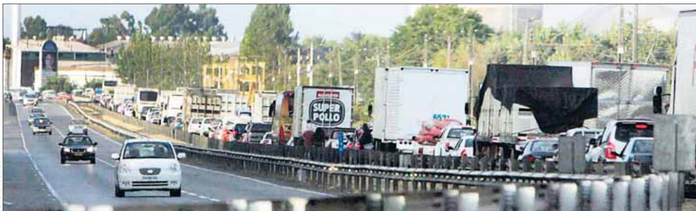
Sin fecha clara para sus arreglos está el Puente Guaiquillo, cerca de Curicó.
