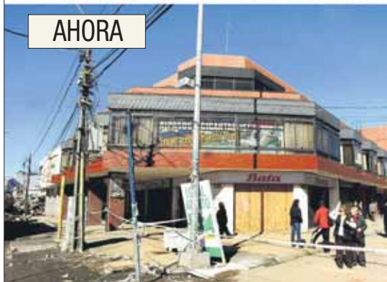
En San Martín con Colón, la retirada de los escombros permitió reabrir parte del comercio.
