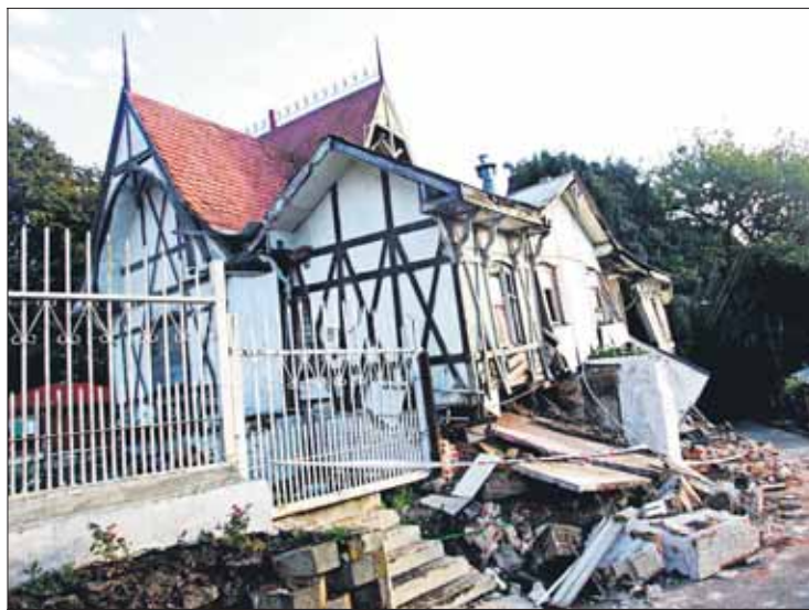
La entrada y el edificio de recepción del parque quedaron completamente destruidos.
